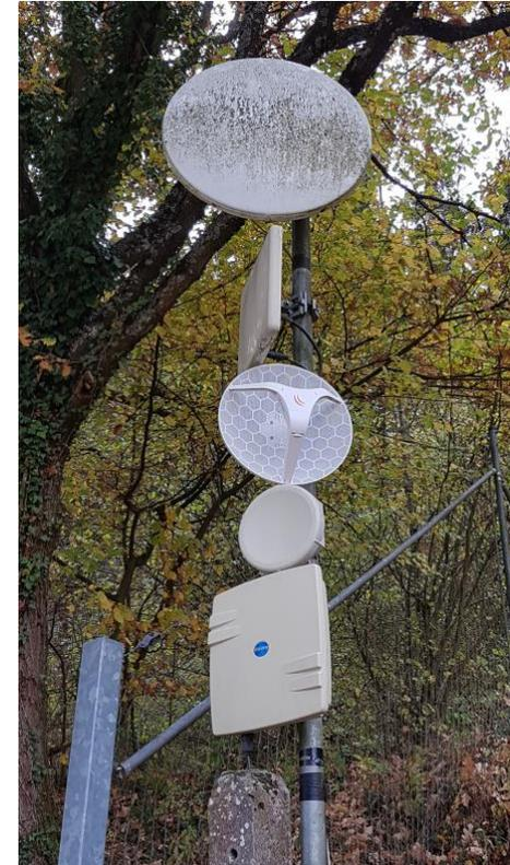
Austausch der 5 GHz Strecke **Alm – Anlagestrasse** auf 60 GHz (Länge: 1,2 km)
